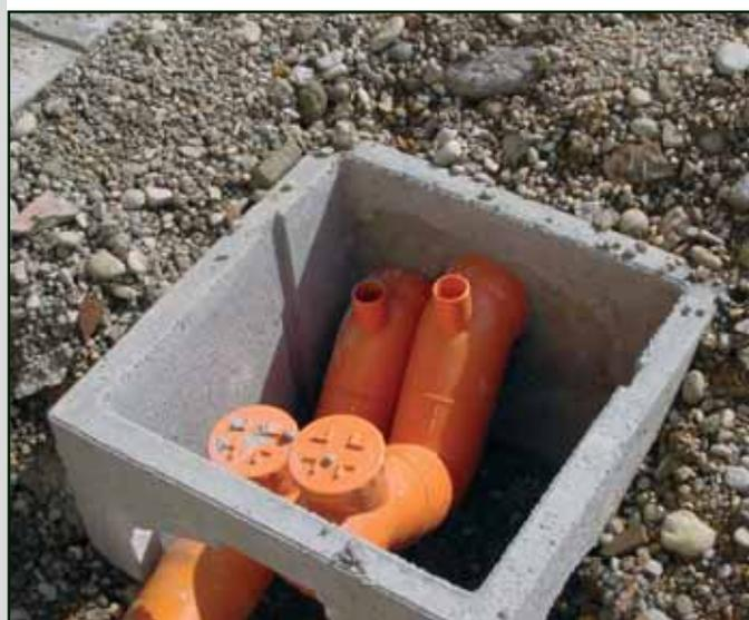
Fornitura e messa in opera di sifone monolitico in PVC, di diametro pari a \_\_\_mm con giunzione ad incollaggio/o-ring, dotato di n° \_\_\_ tappi ispezione a vite di diametro pari a \_\_\_mm, predisposto alla ventilazione mediante la presenza di n° \_\_\_ sfiati e con battuta sifonante almeno maggiore di 1/10 rispetto al diametro del sifone stesso.
